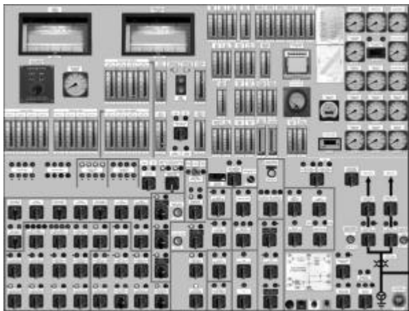
Figura 3. Composición de cuatro paneles virtuales correspondientes a los sistemas de control de turbina y generador eléctrico.
